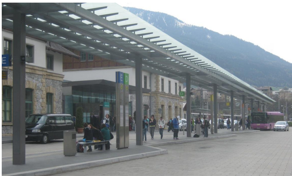
Rys. 12.3.2. Perony autobusowe przed dworcem kolejowym w miejscowości Landeck (Austria). Zaprojektowanie peronów w taki sposób ułatwia ich opuszczenie przez autobus. Źródło: zbiory własne TRAKO.
